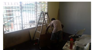
Renovierung in der Wohnung
